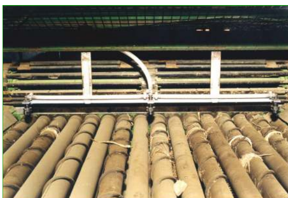
Der 1 Meter lange Sprüharm über den Förderrollen
