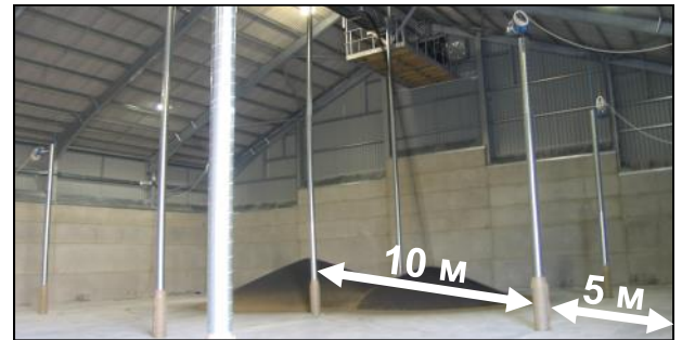
Сійка P3 — приблизно від 350 до 900 тонн на блок
