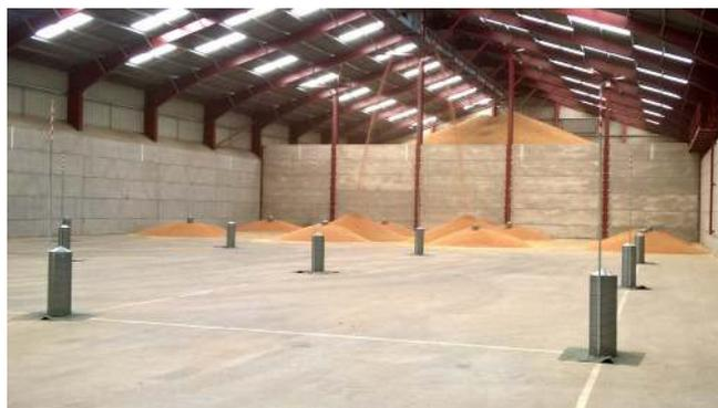
Colonnes FloorVent - idéales pour le stockage de volume important de grains et les tas profonds
