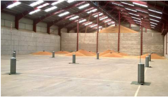
FloorVent-Sockel eignen sich ideal für große, tiefe Erntegutlager
