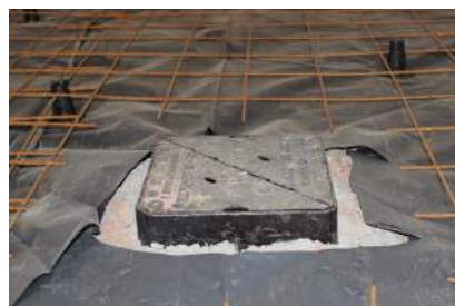
Für die Installation werden Standardbaustoffe eingesetzt
