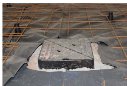
Para su instalación se utilizan materiales de construcción estándares
